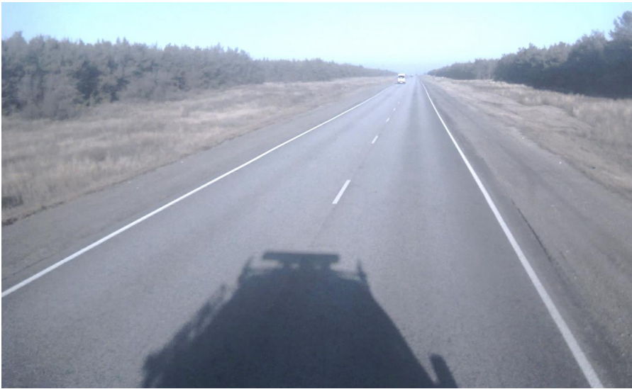
М-6 «Каспий» км 901+830, с модификатором на основе АРП, видимых дефектов не обнаружено
