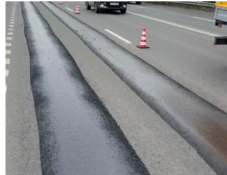
Отремонтированные полосы наката
