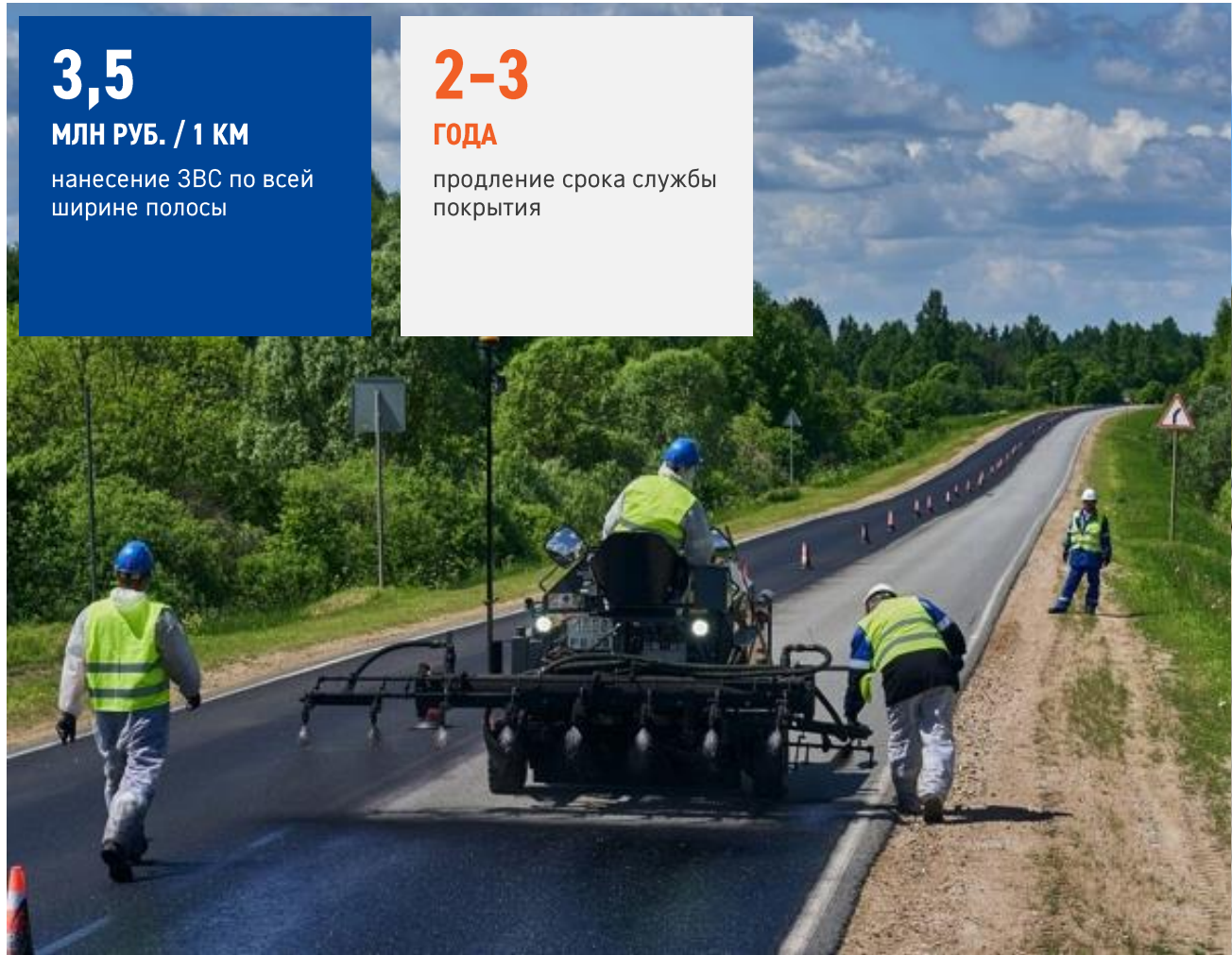
Механизированное нанесение ЗВС
