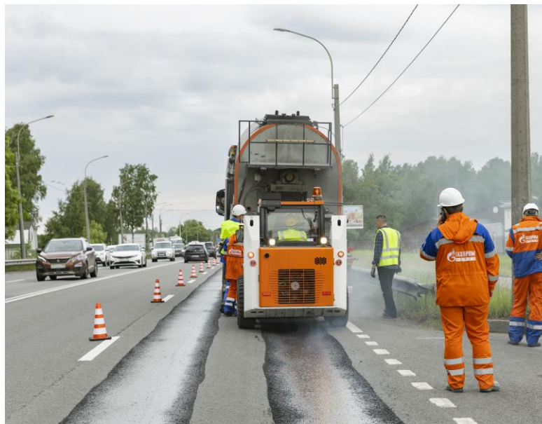
Укладка литого асфальтобетона в колею
