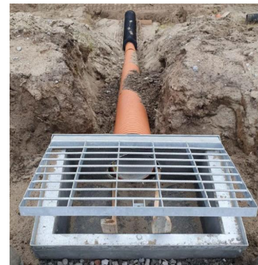
Конструкция водосбросов закрытого типа с устройством в кармане колодца полной заводской готовности с откидной крышкой
